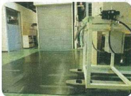
工場内の床の保護
