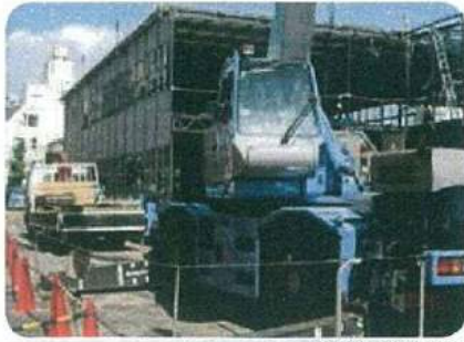
駅舎工事現場
