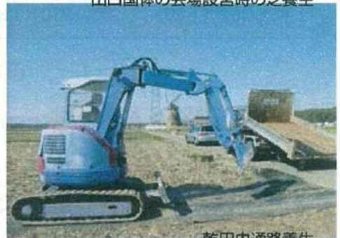
乾田内通路養生
