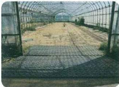
ビニールハウス入口養生
