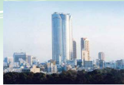
六本木ヒルズのタイル地下・地下駐車場において当社製品が60万個使われました。
