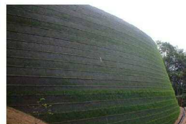
アデムユニットキャップ工法
