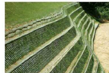
グリーンテラスウォール工法
