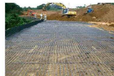
アデム敷設状況
