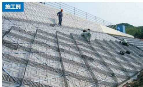
既存コンクリート護岸上における植生基盤層の構築
