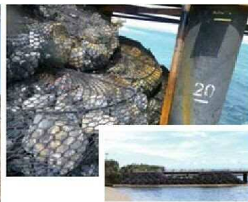
港川高架橋下部工(下りP10)工事(沖縄県)
