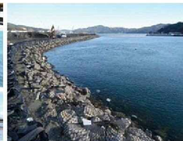
中詰め材にコンクリートガラを使用(岩手県)
