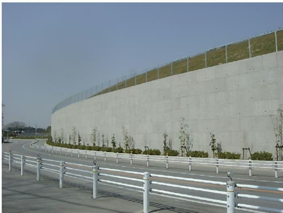
民間工事：愛知県岡崎市
