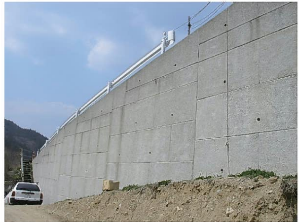
多治見砂防国道事務所：温川 中津川市
