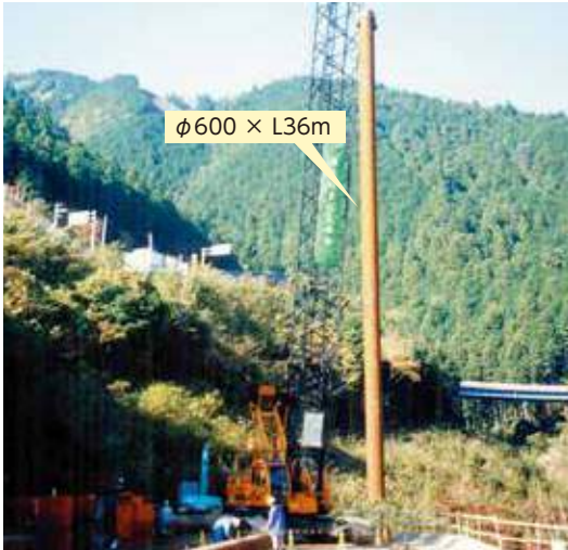
■高強度・長尺抑止杭によるダム災害対策
