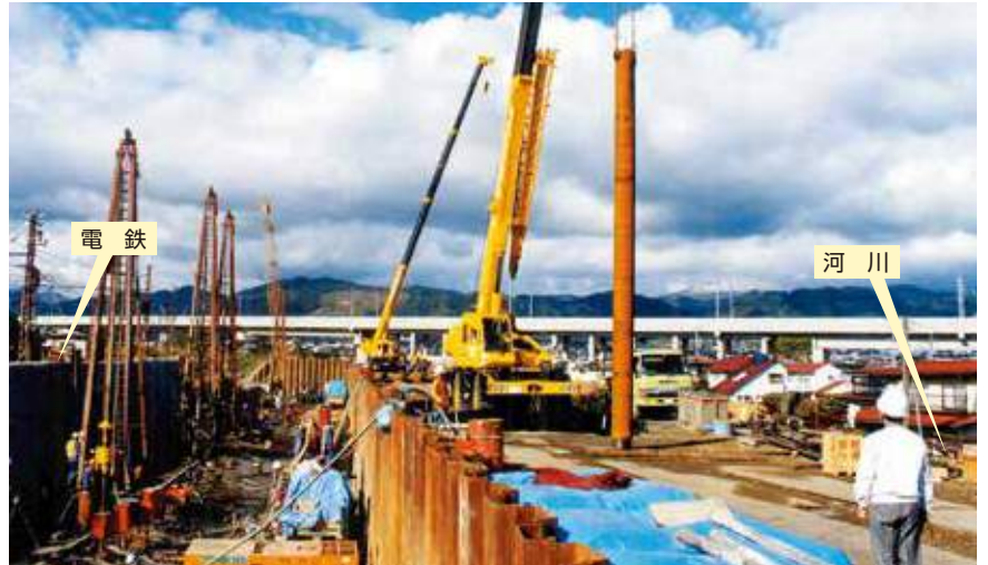
■ねじ継手による鉄道・河川災害対策
