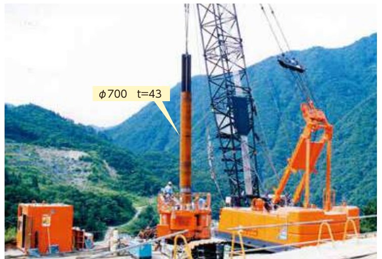
■大口径抑止杭 + ねじ継手による鉄道災害対策
