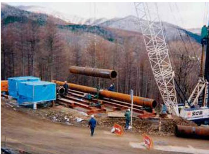
■大口径抑止杭による道路災害対策
