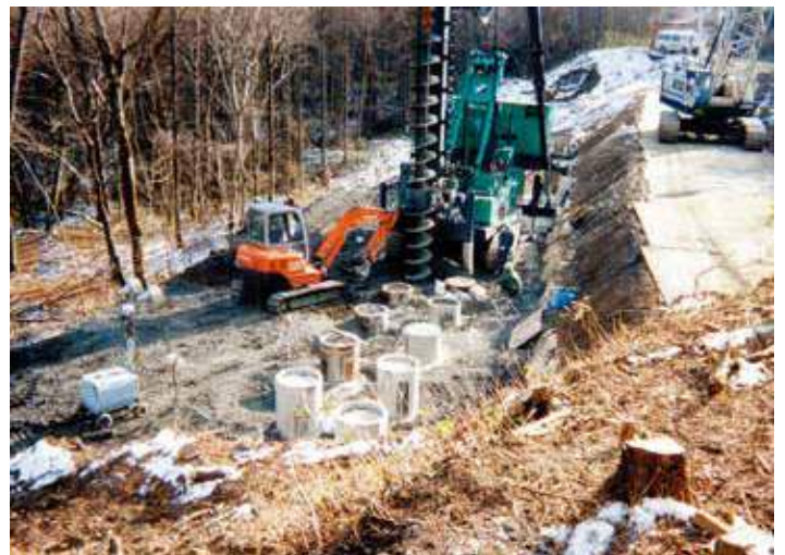
■大口径抑止杭 + ねじ継手による鉄道災害対策
