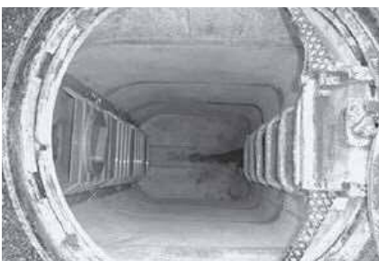
● A1マンホール
