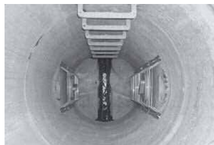
● 2箇所付け施工
