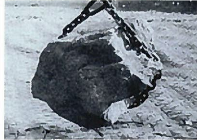
①重さ10tの石をつり上げて10mの高さより落とす。
