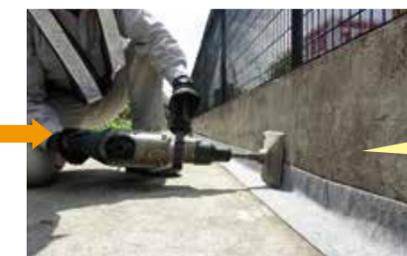
隙間から徒長するくず(葛)をカットし、目地シートを施工
