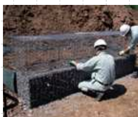
③中段及び最上段本体設置・組立て及び中詰め工程
