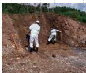
①設置箇所の掘削・整形作業
