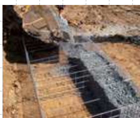
②最下段本体設置・組立て及び中詰め工程
