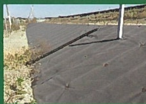
法面・道路脇
