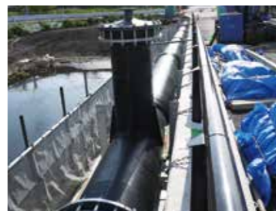
橋梁部管路布設状況
