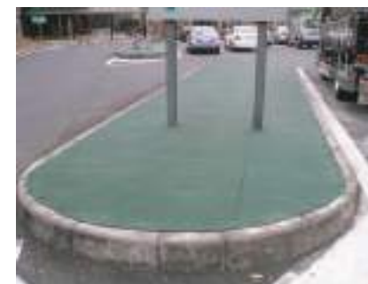
東日本高速道路(株) 東北自動車道(埼玉県)
