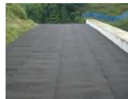
西日本高速道路(株) 阪和道(和歌山県)
