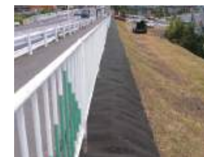
国土交通省 国道246号(神奈川県)
