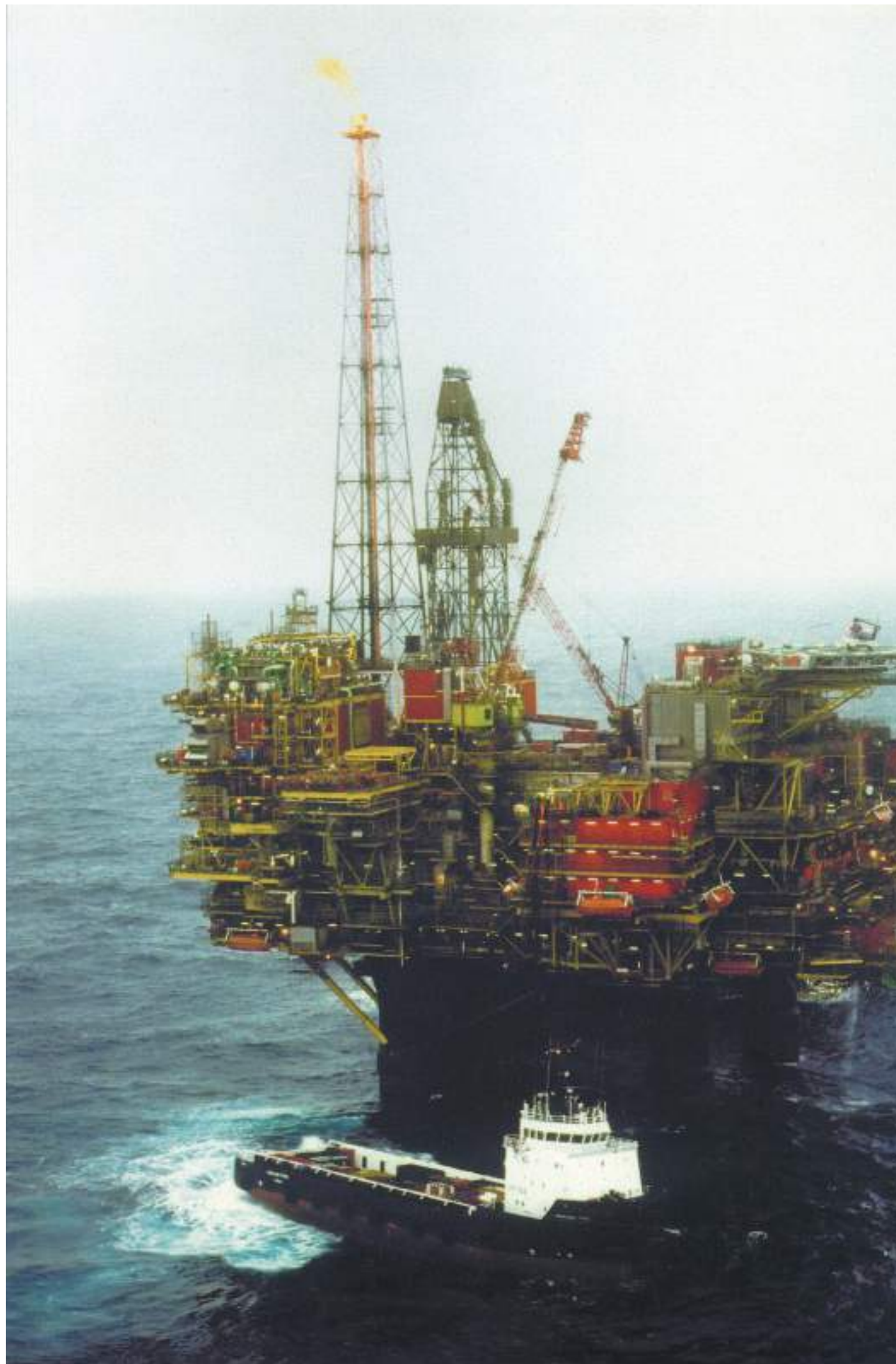
Foto: Hardy Schmitz Elektro-Technik
