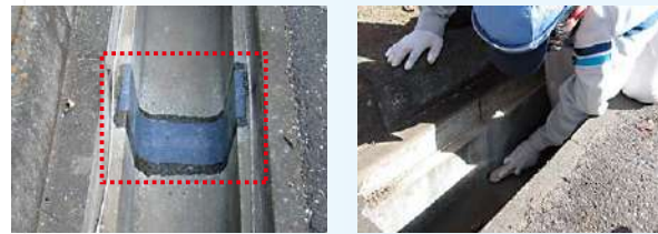
補修箇所のケレン、プライマー塗布、ポリマエースUG貼付け、2日間養生して完了
