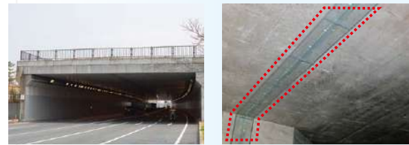
既存の目地材表面部分を除去し、上からの雨水を流す樋として採用されました。
