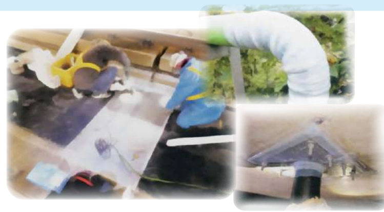
新幹線高架橋の絶縁目地を外側よりポリマエースUGを貼って施工し水の漏水を補修しました。 下地調整から施工完了まで30分程度
