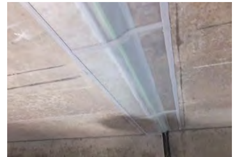
段差のある目地に施工した例
