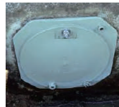
分水栓の補修
