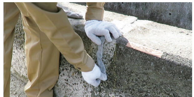
コンクリートのひび割れ補修
