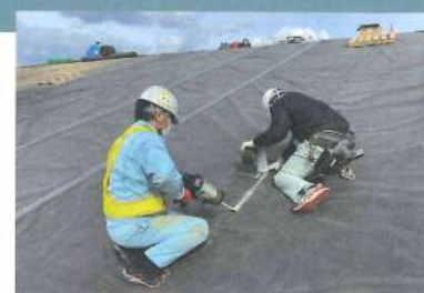
接着部(シート間)に隙間がないことを確認/接着剤塗布面にゴミや埃がないことを確認 専用接着剤1本で10cm幅×2.5m程度を塗布後、帯シートを貼り合わせて接合する 接着剤用帯シート貼り合わせ後は、接着部が剥がれないように、完全硬化するまで接着部周辺を歩かないように注意する
