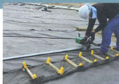
熱融着機の施工条件(温度、速度)を確認して融着する
