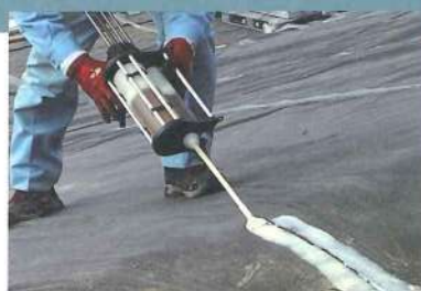
接着部(シート間)に隙間がないことを確認/接着剤塗布面にゴミや埃がないことを確認 専用接着剤1本で10cm幅×2.5m程度を塗布後、帯シートを貼り合わせて接合する 接着剤用帯シート貼り合わせ後は、接着部が剥がれないように、完全硬化するまで接着部周辺を歩かないように注意する
