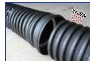
②上流側の管端部を差し込み管をねじ込みます。
