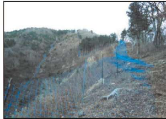
(ネット設置施工例)
