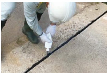
▲橋梁伸縮部の充填に
