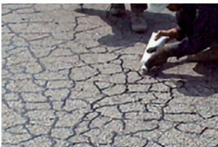
▲アスファルトクラックの補修に
