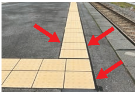
▲舗装と点字ブロックの目地に
