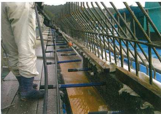
土木：橋梁での水洗出し作業中
