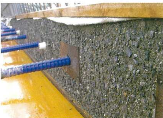
土木：洗出し後の打ち継ぎ面
