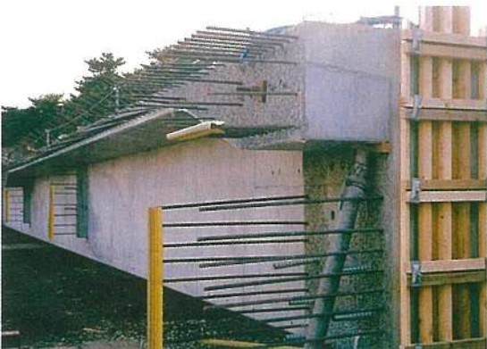
土木：橋梁での使用例
