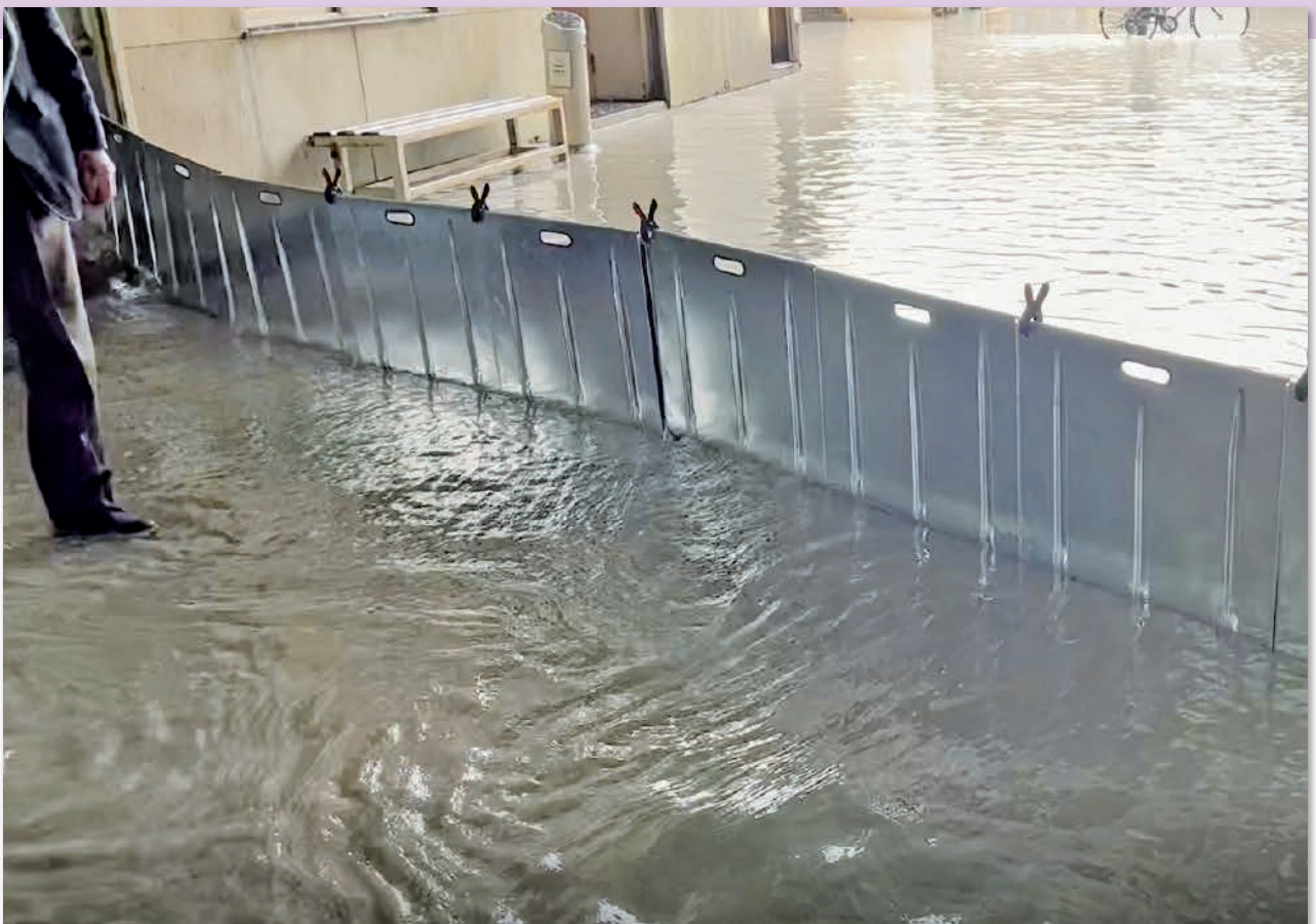
豪雨発生時に設置
